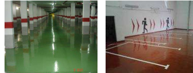
Suelos de pintura epoxi
