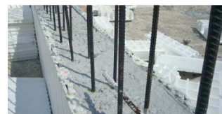
Encofrados para muros de hormigón EPS (poliestireno expandido)
