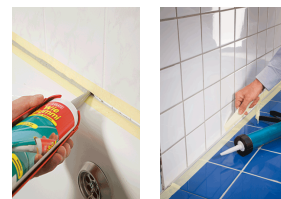
Sellado de juntas de silicona
