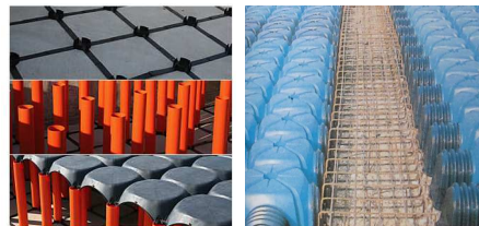
Casetones de PP para forjados reticulares
